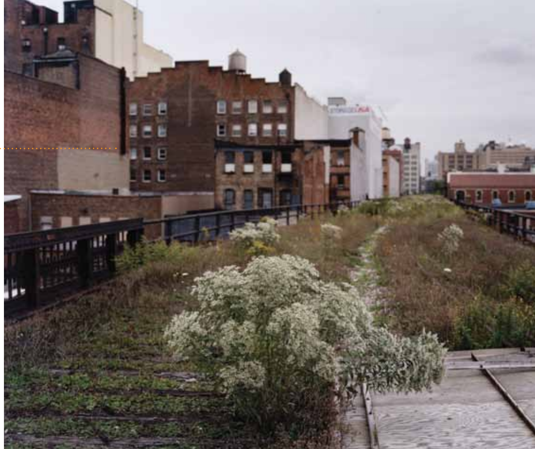
После прекращения движения поездов в 1980 году и до того времени, как High Line стал парковой зоной в 2009 г., он был местом концентрации сорняков, мусора и ржавчины. Снос зданий только ухудшил ситуацию.
